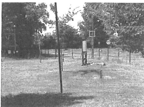
27. szennyvíz akna (fűves rész, északi oldal)
