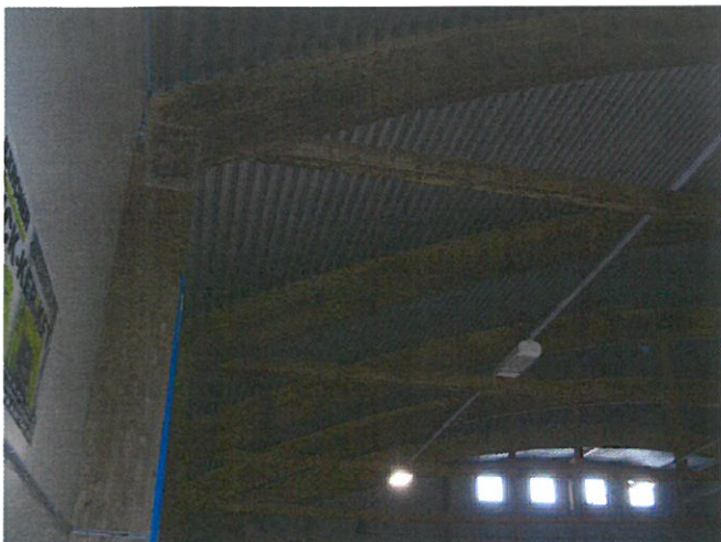
1. fénykép A jobboldali oszlopok és tartók penészesedése 2012-ben
