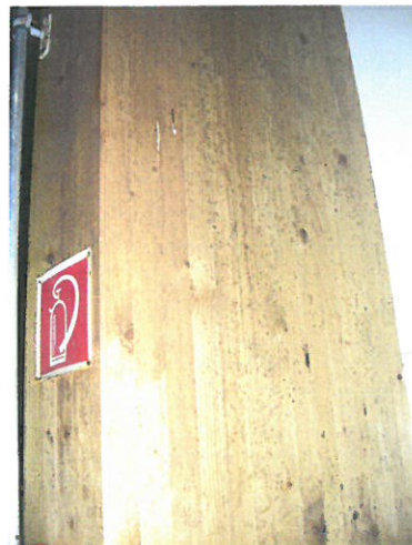
1. fénykép A jobboldali oszlopok és tartók penészesedése 2012-ben
