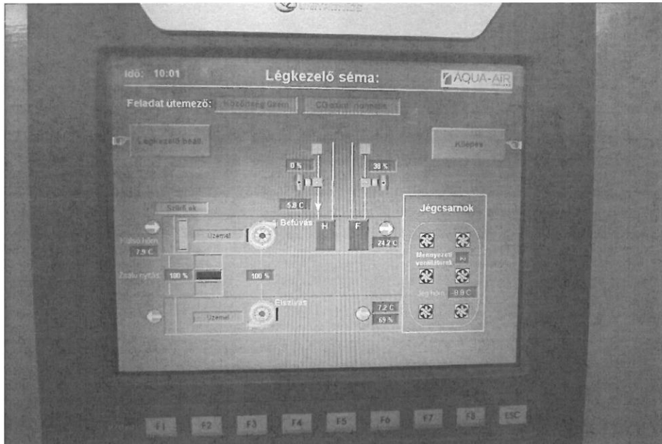
2. kép: Légkezelő sémája a felügyeleti rendszeren
