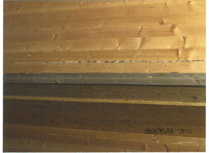
8. fénykép Kismértékű penészesedés a keresztelátó alatt
