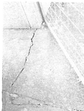
33. repedezett burkolat
