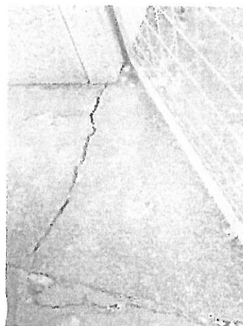
33. repedezett burkolat
