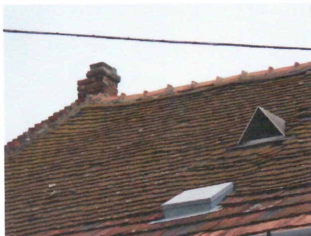
02. megrogyott tetőszerkezet
