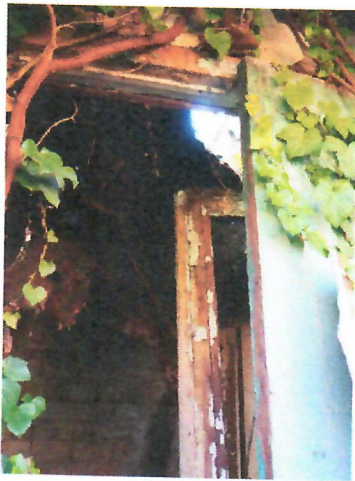
07. növényzettel benőtt épület
