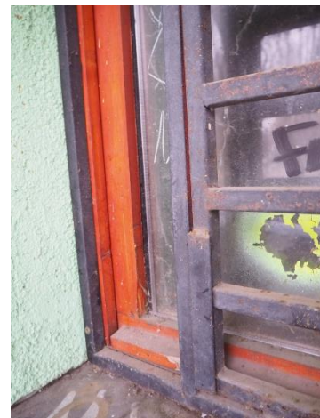
04. ráccsal védett faszerkezetes nyílászáró
