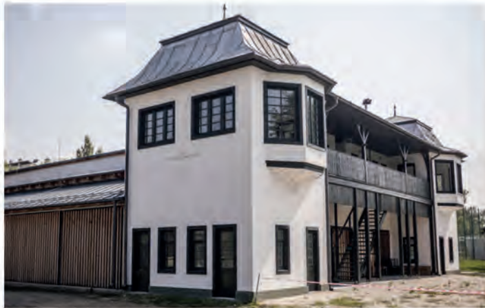
3. számú Hullám Csónakház hátsó homlokzata, forrás: http://www.welovebudapest.com
