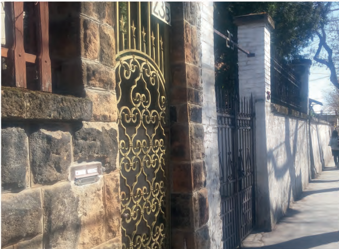
támfalak, kerítések a Nagy Győri István utcában, a karakteres fasor meghatározó eleme a településképeknek
