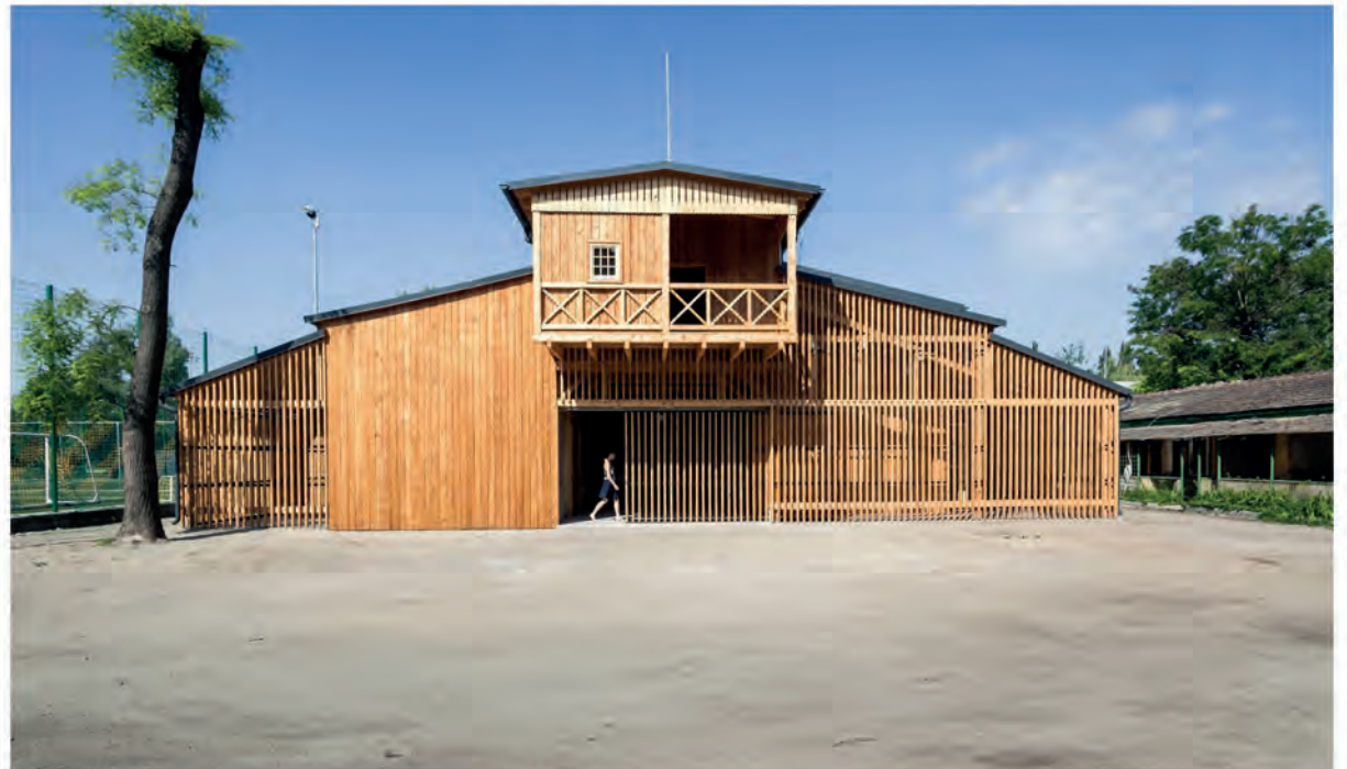
TÉR_KÖZ 2013 pályázat útján felújított, 3. számú Hullám Csónakház
