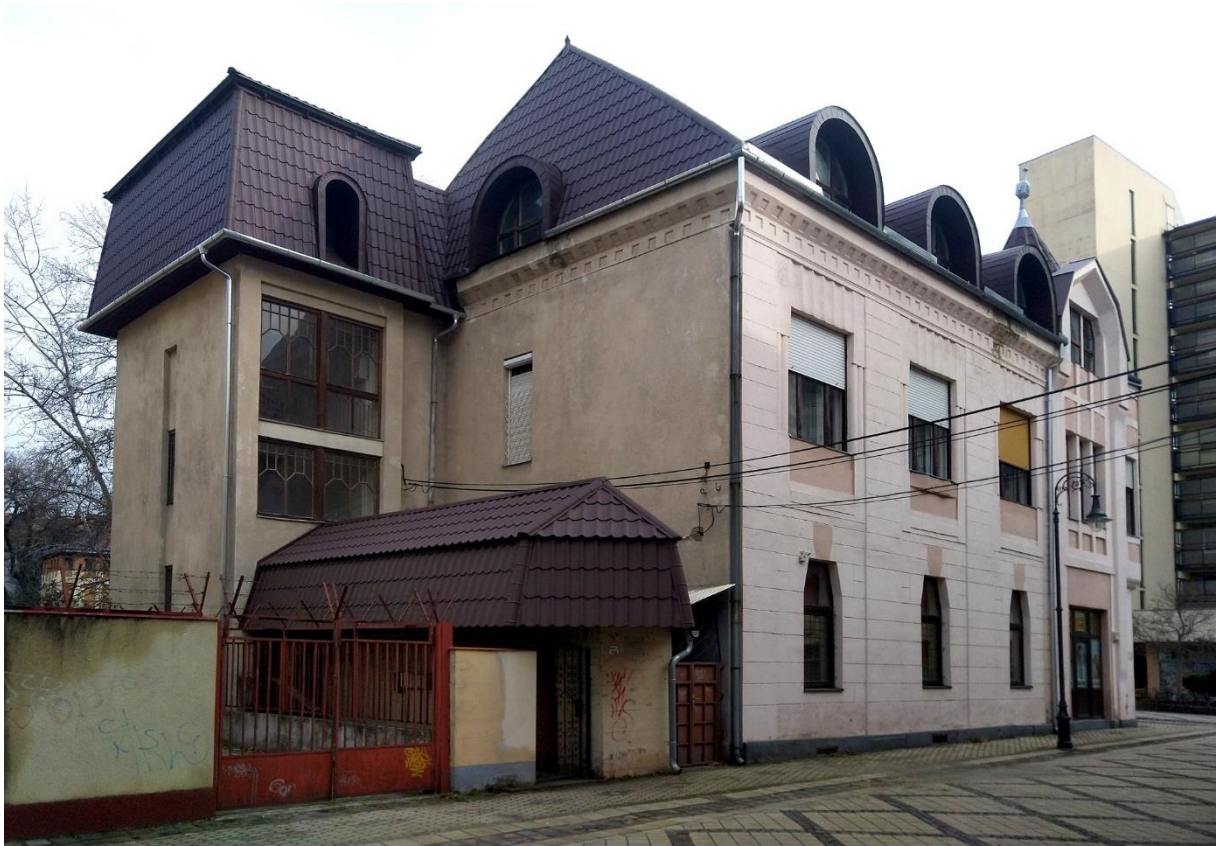
Épület Széchenyi utcai nézete. A lépcsőház és a földszinti bejárati épületrész utólagos bővítés.
