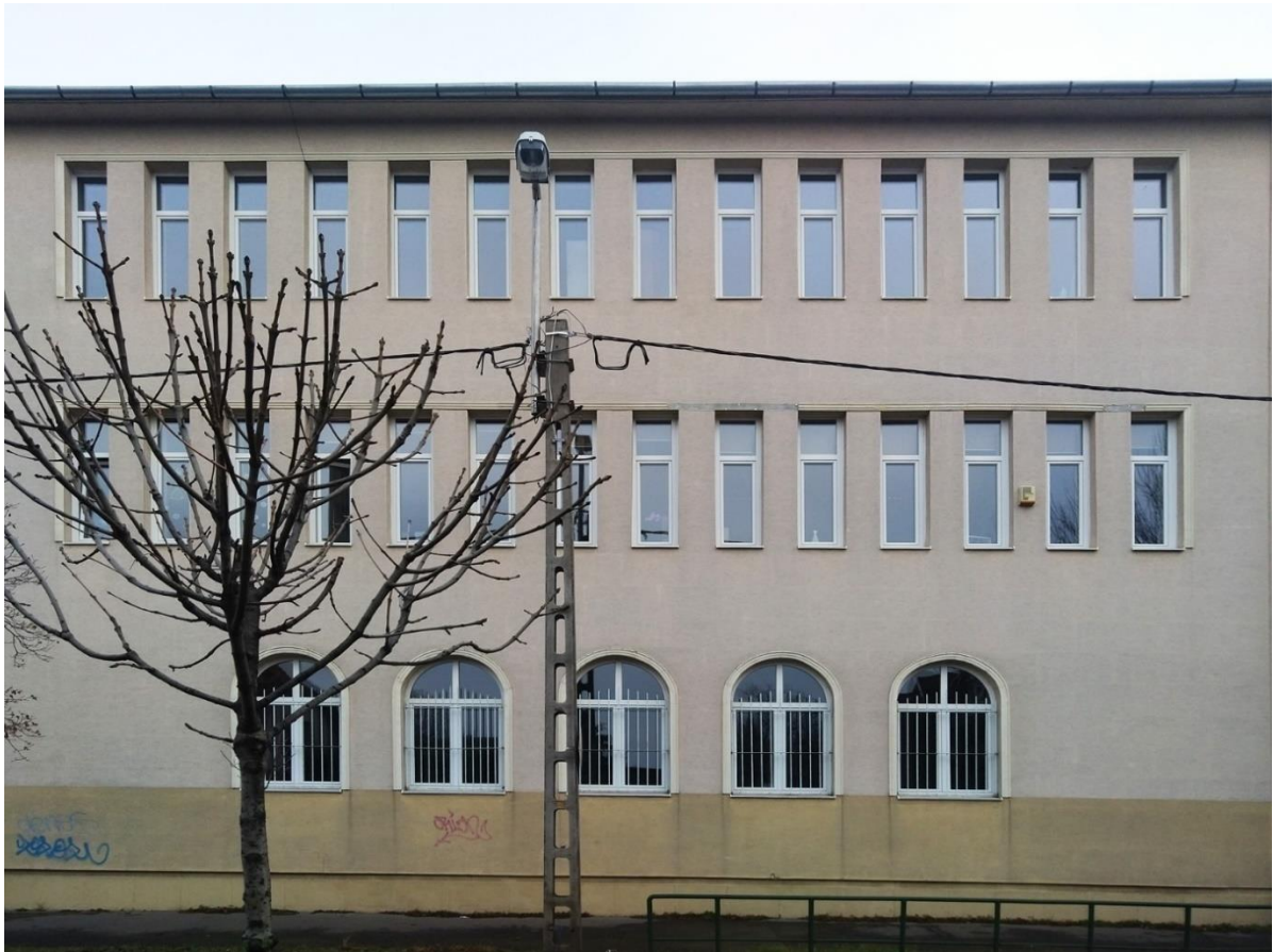
Mártírok utca 47. sz. épület középső homlokzatrésze
