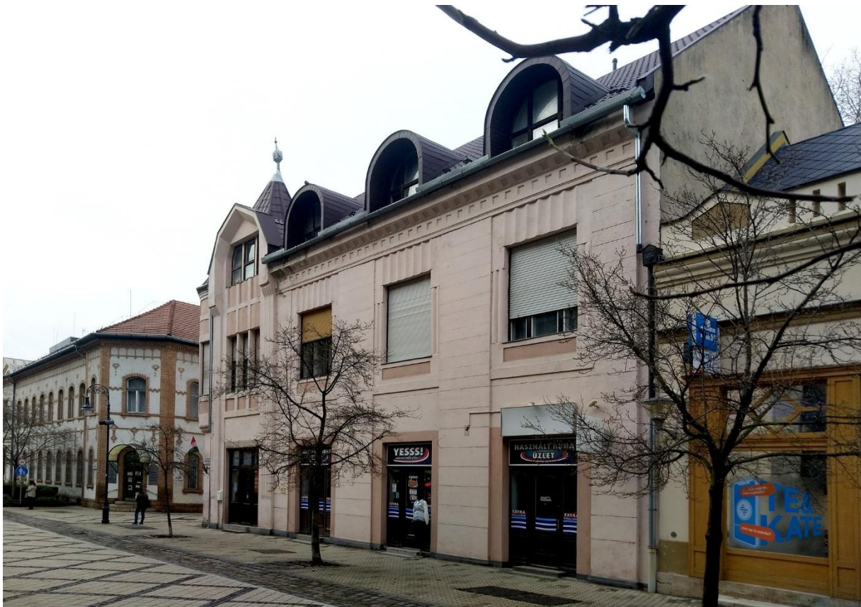
Kossuth Lajos utca 37/a. sz. épület utcaképi megjelenése
