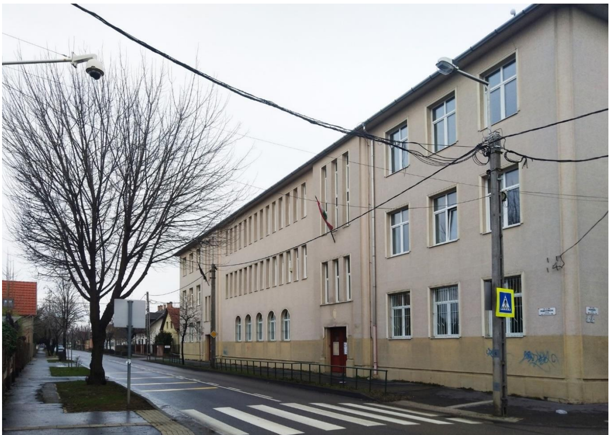
Mártírok utca 47. sz. épület dél felőli nézete
