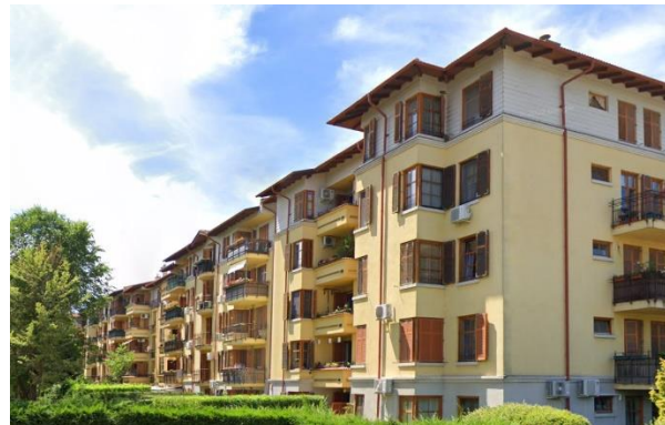
Klíma berendezések zavaró elhelyezése
