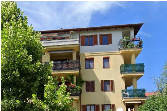
Leszerelt zsalugáterek a homlokzatokon
