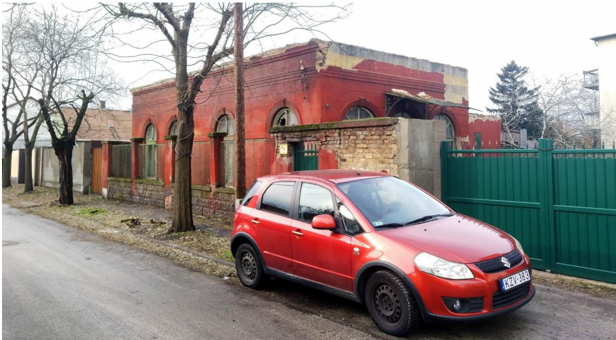
Épület állapota a tetőszerkezete nélkül 2023 december 14-én.
