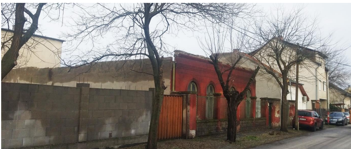
Épület állapota a tetőszerkezete nélkül 2023 december 14-én
