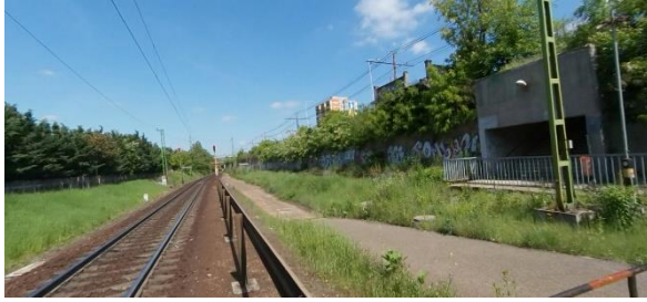
vasúti terület a Pesterzsébet megállóhely melletti aluljáróval (Google Street View 2017)
