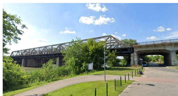
Csepeli átjáró (Google Street View 2024)
