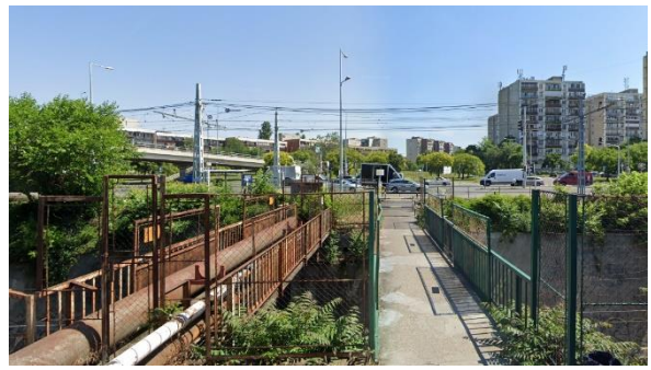
gyalogos híd a 150. sz. vasútvonal felett a Serény utca folytatásában (Google Street View 2024)
