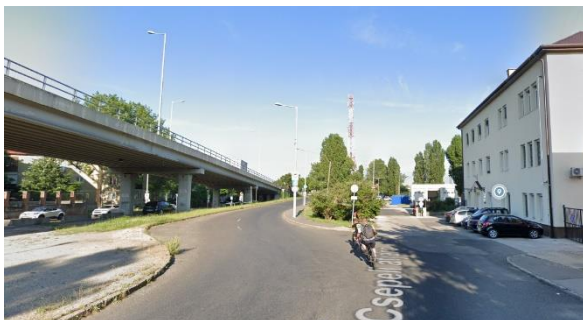
Csepeli átjáró és tőle északra fekvő gazdasági telephely (Google Street View 2024)
