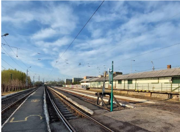
Pesterzsébet Felső vasútállomás vasúti peronja (Google Street View 2022)
